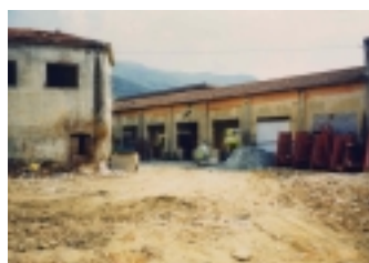
13 alloggi duplex tipologia schiera prima dell'intervento
