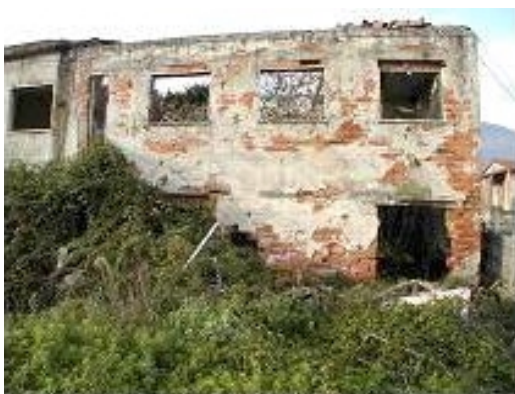
4 alloggi tipologia in linea prima dell'intervento
