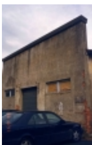
blocco commerciale prima dell'intervento
