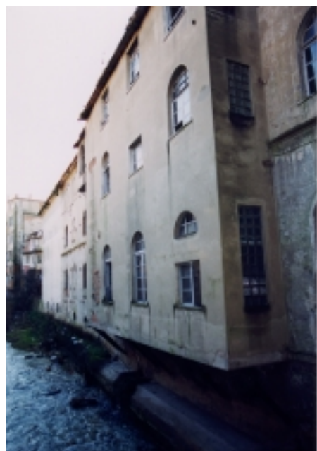
Veduta del prospetto sul fiume prima dell'intervento di recupero
