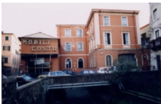
Veduta principale prima del recupero
