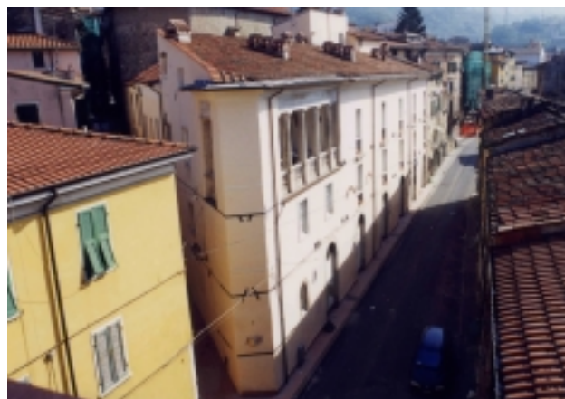
dopo l'intervento di recupero
